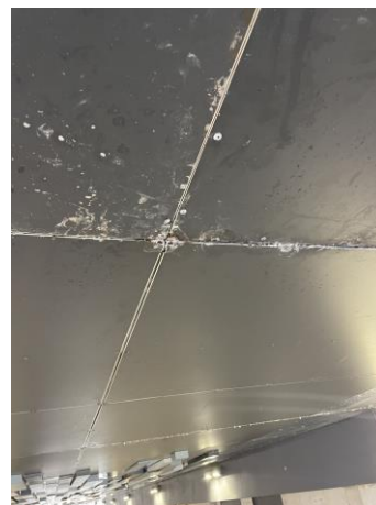
4. Pėsčiųjų tunelio požeminės erdvės lubų dabartinė situacija. Esamos tunelio lubos neatitinka saugumo standartų, yra pažeistos aplinkos veiksnių.
